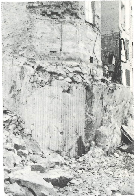
Den färdiga slitsen före och efter sprängning
