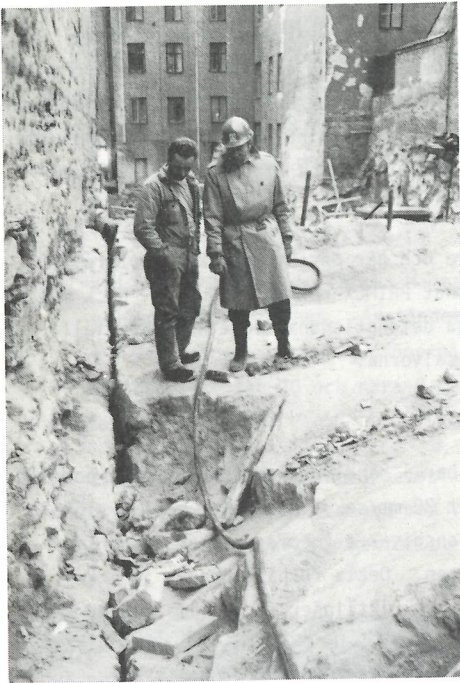
Den färdiga slitsen före och efter sprängning
