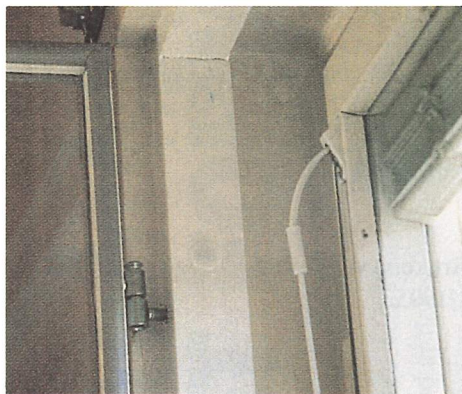
...förbättring av isolering i fönster med som här en extra innerruta
