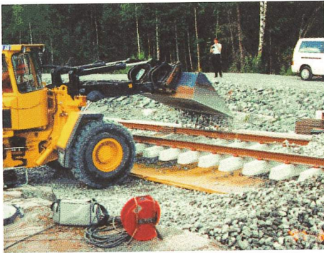
Figur 7 Ballastmattor och slipermattor installeras i spåret
