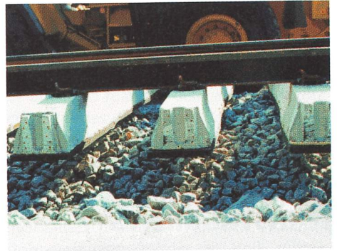
Figur 7 Ballastmattor och slipermattor installeras i spåret
