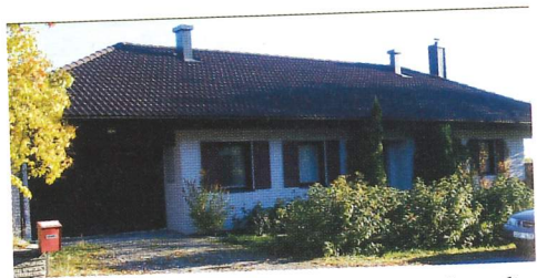
Figur 4. Villan med utgrävd källare. Betongplattan ligger i markplanet. Mätningen i grundmuren utfördes i källarplanet.
