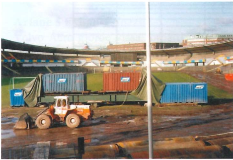
Förprov på 2 st grävpålar 1992
