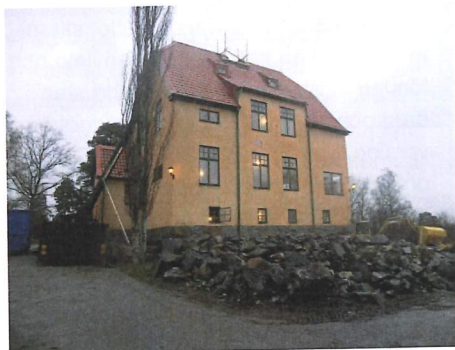
Sprängning sker under detta hus, som ligger i Djursholm.
