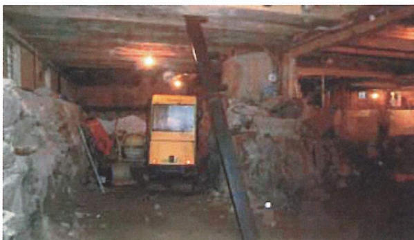
Sprängning i källare. Djursholm. Foto: Henry Sandström
