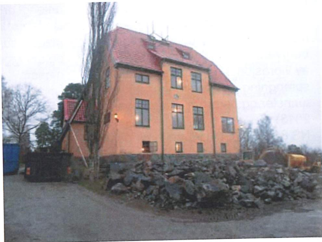
Sprängning under ett hus i Djursholm. Foto: Henry Sandström
